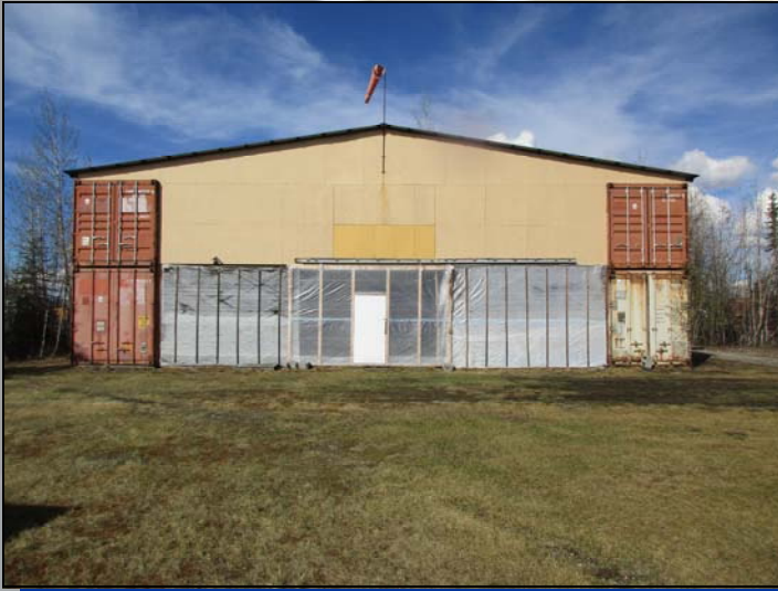
EAA Chapter 1129 Hangar 2206 Frank Avenue.
